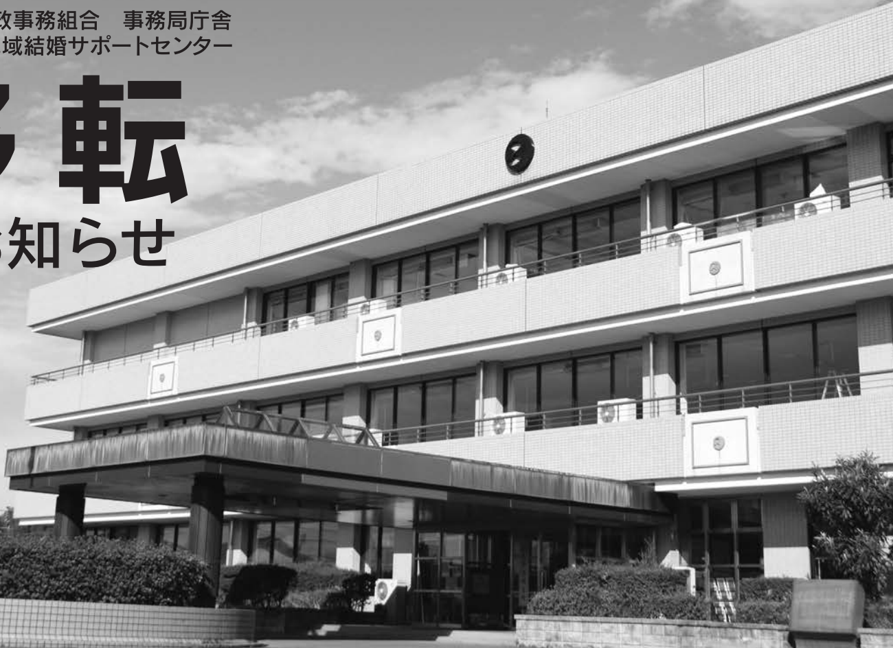
写真：玉名市役所岱明支所
