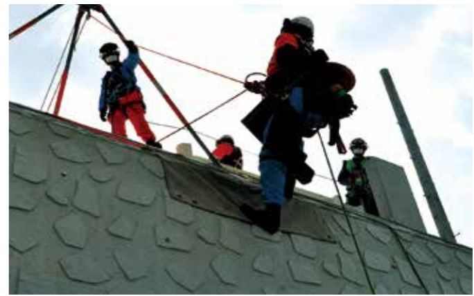
ロープを使用し壁を登る様子
