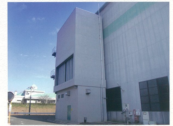
復水器棟 蒸気タービン、発電機、蒸気復水器が配置されています。
