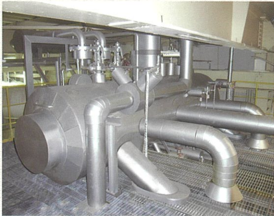
ボイラ ごみ焼却に伴う燃焼ガスから熱を回収し、蒸気を発生させます。
