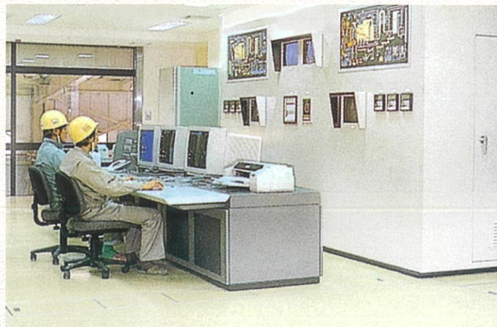
中央制御室・クレーン操作室(補修前)
