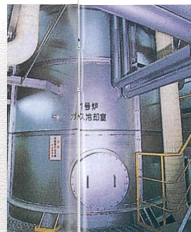
ガス冷却室(補修前)
