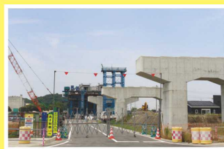
整備中の有明沿岸道路の橋脚
