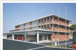
▲荒尾消防署・災害情報指令センター(荒尾市)
